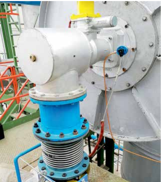
A lato un bruciatore NM installato su di un post combustore. Sopra la sua particolare fiamma.
